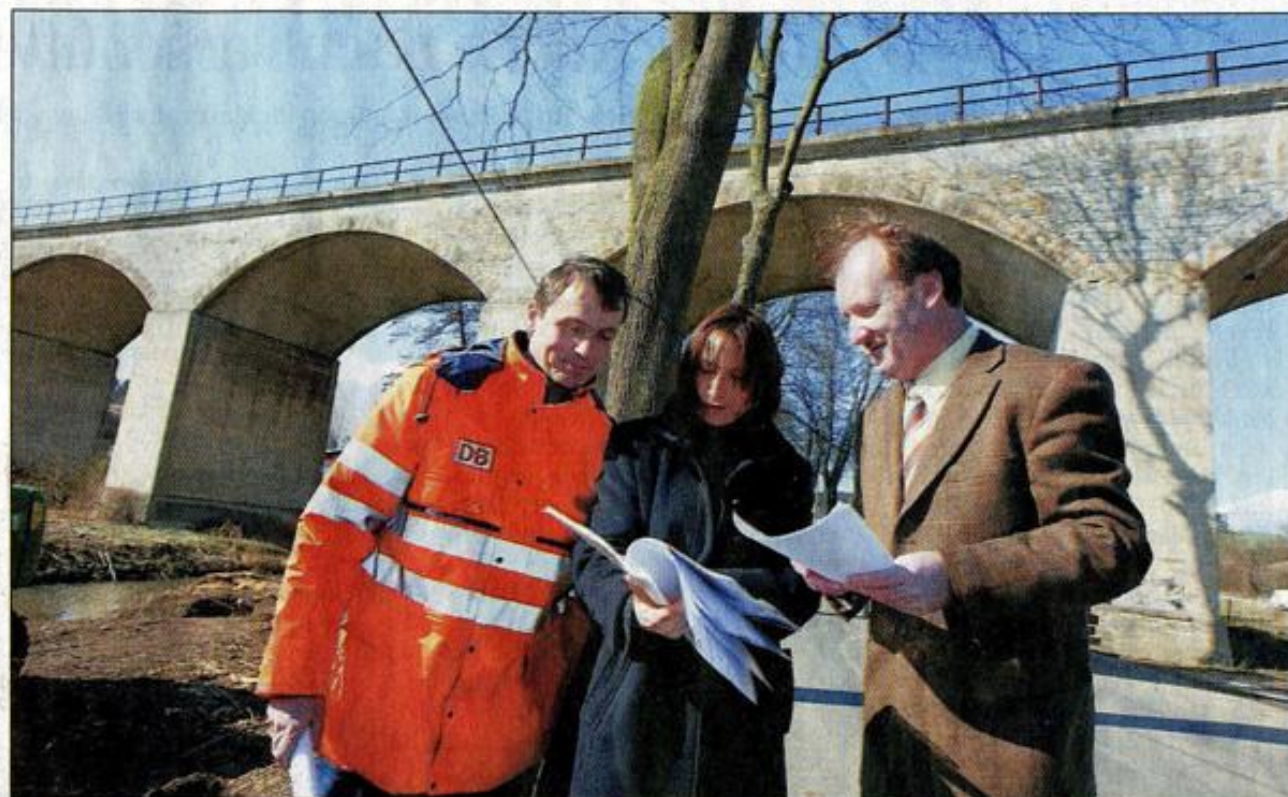
Sie stellten gestern die Pläne der Deutschen Bahn in Straßberg vor: Gert Lanzendorf, Elke Hering und Henning Metzner (von links). Im Hintergrund das Rosenbachtal-Viadukt, das abgerissen wird. —FOTO: ELLEN LIEBNER
